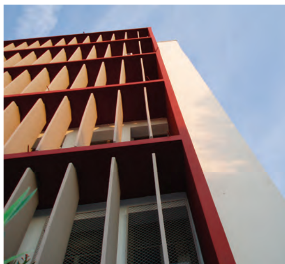
Λεπτομέρεια του κτιρίου της Φ.Μ.Σ.
