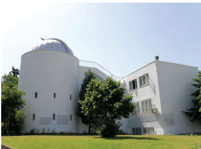
Το κτίριο του Αστεροσκοπείου που εγκαινιάσθηκε μαζί με το κυρίως κτήριο της ΦΜΣ.
